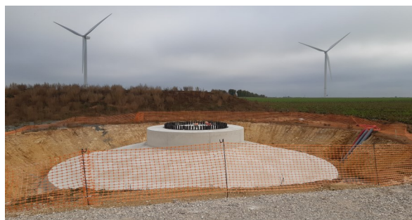
Fondation d'une éolienne de la Ferme éolienne du Bois Élie
